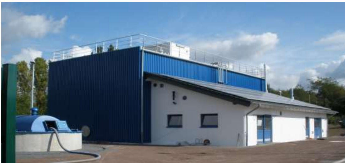
Bild 10: Kompaktfaulung auf der Kläranlage Linz-Unkel
