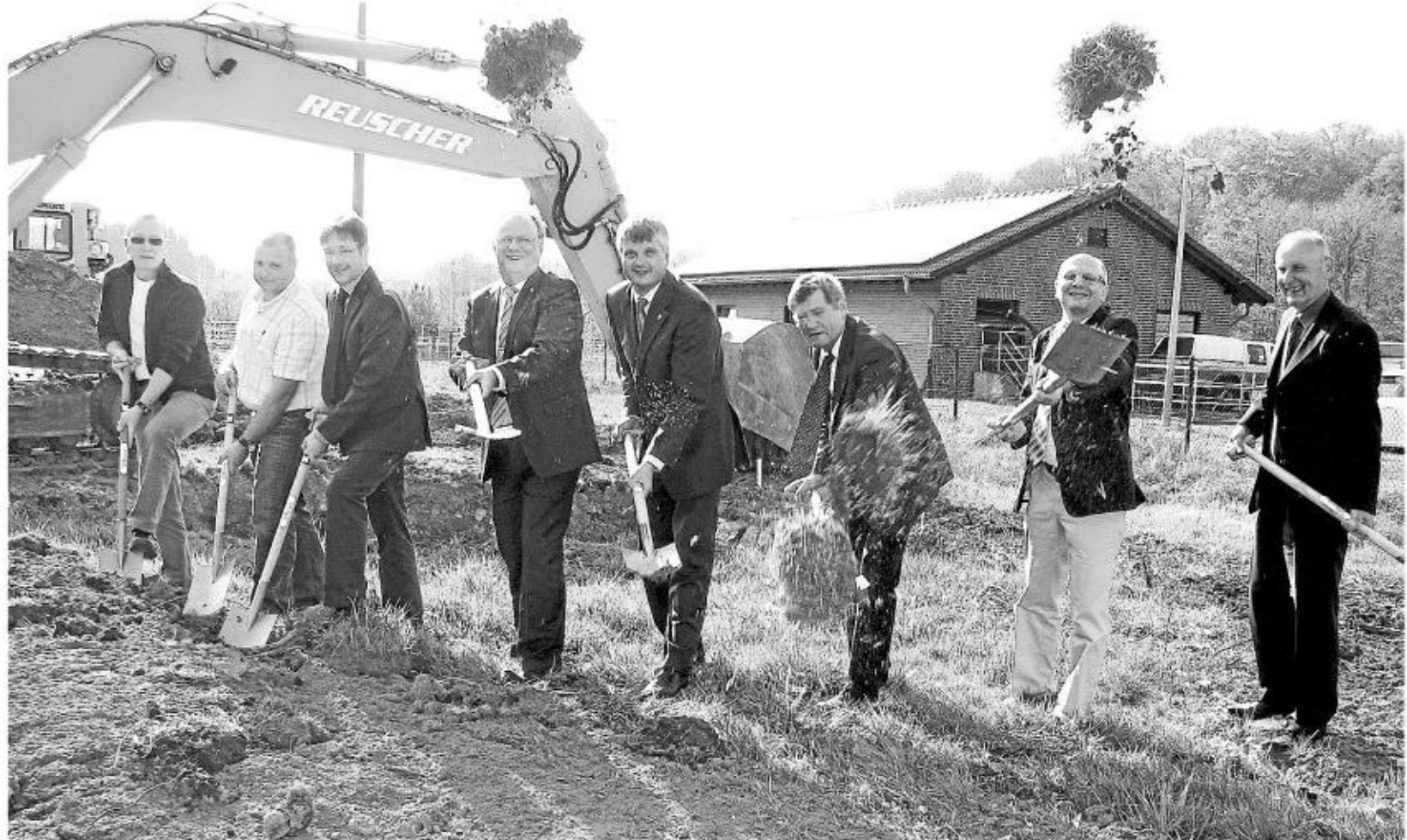
Spatenstich für die Kläranlage (von links): Stefan Wick (VG Wirges), Holger Zilch (Firma Mogendorf und Schmitz), Achim Linder (VG-Werke Selters), die Bürgermeister Michael Ortseifen, Klaus Müller und Bernd Benner, Ingenieur Dr. Klaus Siekmann und Ministerialdirigent Werner Theis. Foto: Thorsten Ferdinand
